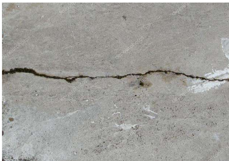
Рис.1 Типовая трещина в асфальтобетонном покрытии.
